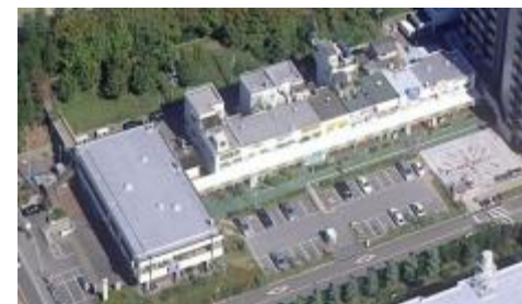
【〔豊中市〕新千里南町近隣センター】
