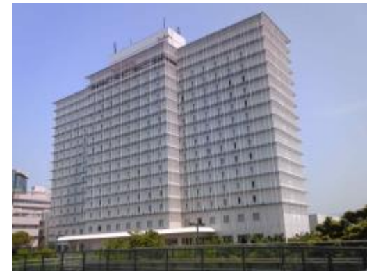
【(信託建物)関西エアポートワシントンホテル】
